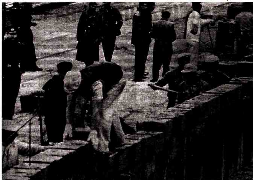
Сооружение Берлинской стены. 1961 г.
